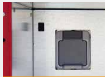
Aufputz Schuko-Steckdose (Elektroinstallation) 230 V mit Deckel, Schutzart IP 44.
