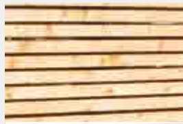
Holzbelattung Lärche, 55 x 35 mm waagrecht, lasiert in Eiche rustikal
