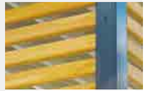
Holzbelattung Fichte, 55 x 35 mm, waagrecht, lasiert in Eiche rustikal
