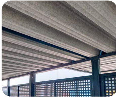
↑ Trapezblech Dachblechunterseite Hochtrapezbleche mit Vlies als Kondenswasser- und Lärmschutz
